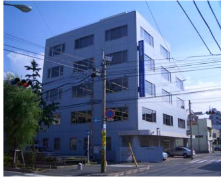
▲1 改装前 北東側外観
