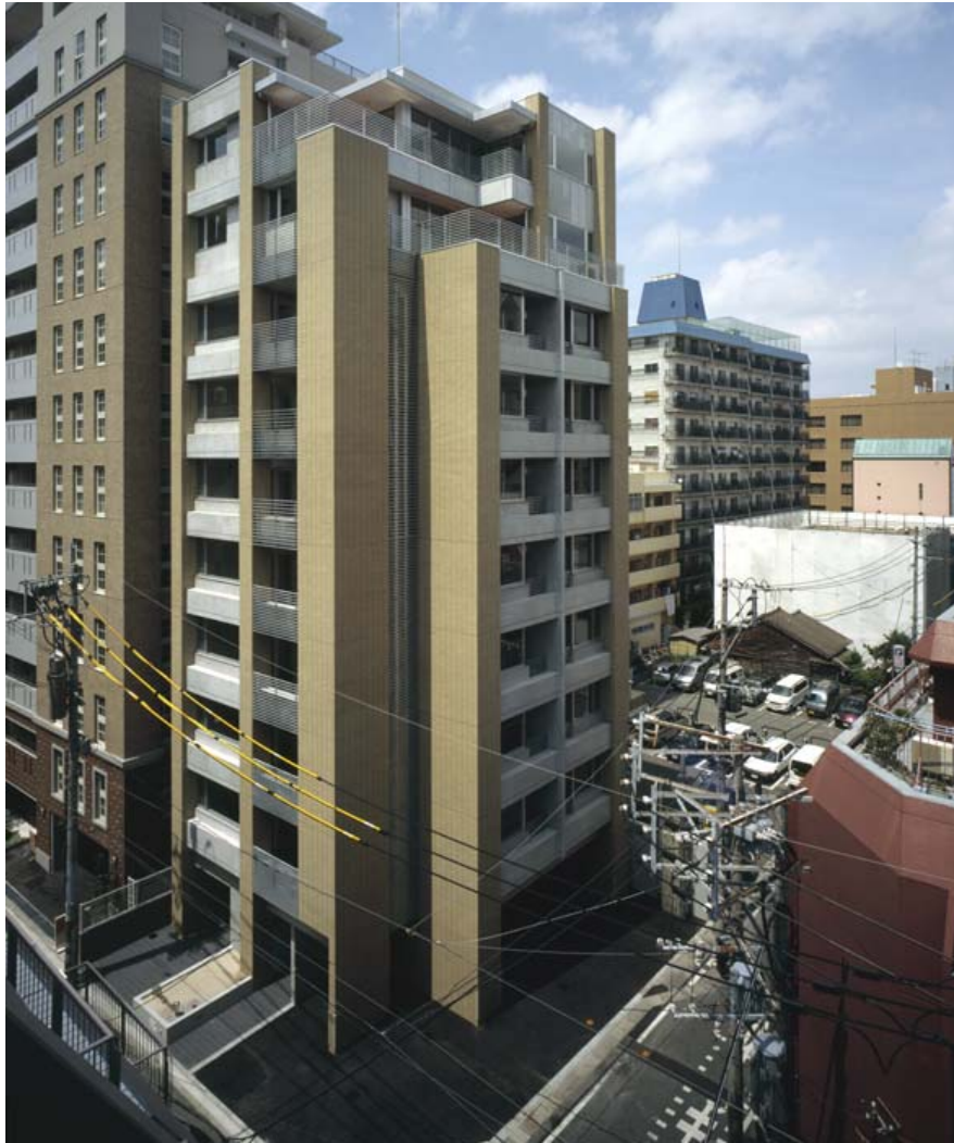
▲7 建物全景を見る
