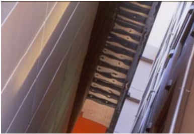
外部階段上部を見る / View Of Above The External Staircase
